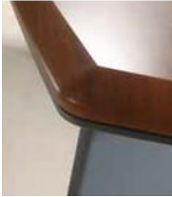
rys.2 profilowanie krawędzi oraz łączenie płyt
