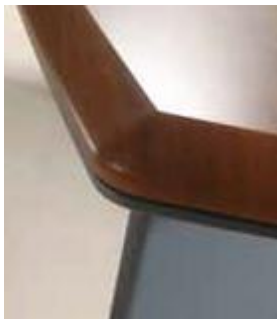
rys.2 profilowanie krawędzi oraz łączenie płyt
